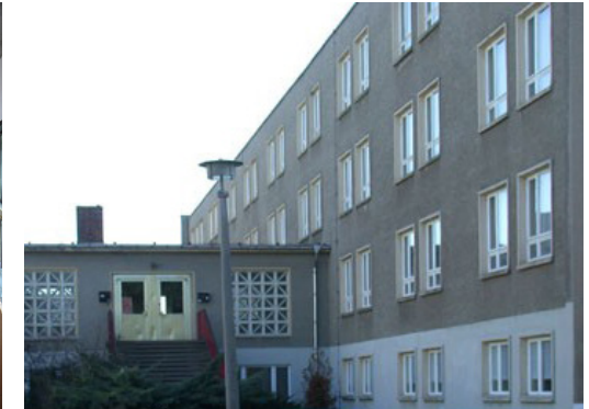
Fassadenansicht vor Sanierung
