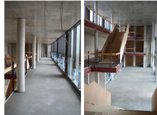
Innenraum in Entwurf und Bau
