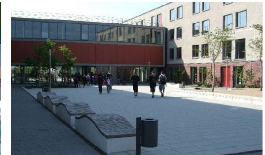
Fassadenansicht nach Sanierung
