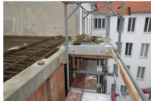
Befestigung der Balkone mittels Isokörben
