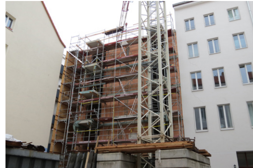
Rohbau des Wohnhauses
