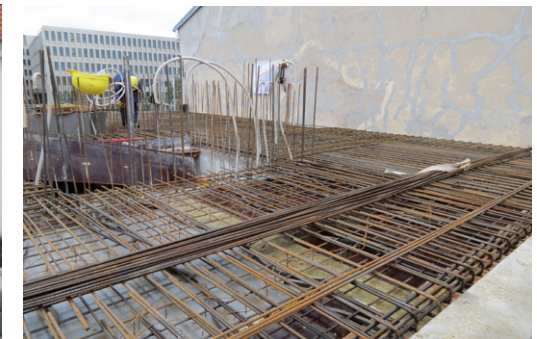
Bewehrung der Decke über dem 4. OG
